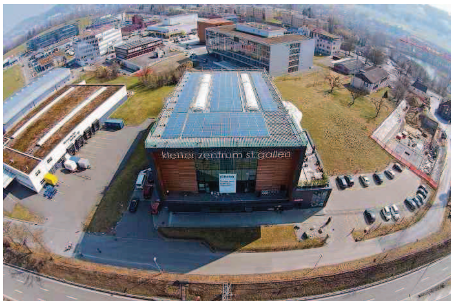
Photovoltaik und Erdwärme: Das Kletterzentrum im Westen von St. Gallen setzt auf erneuerbare Energie.
